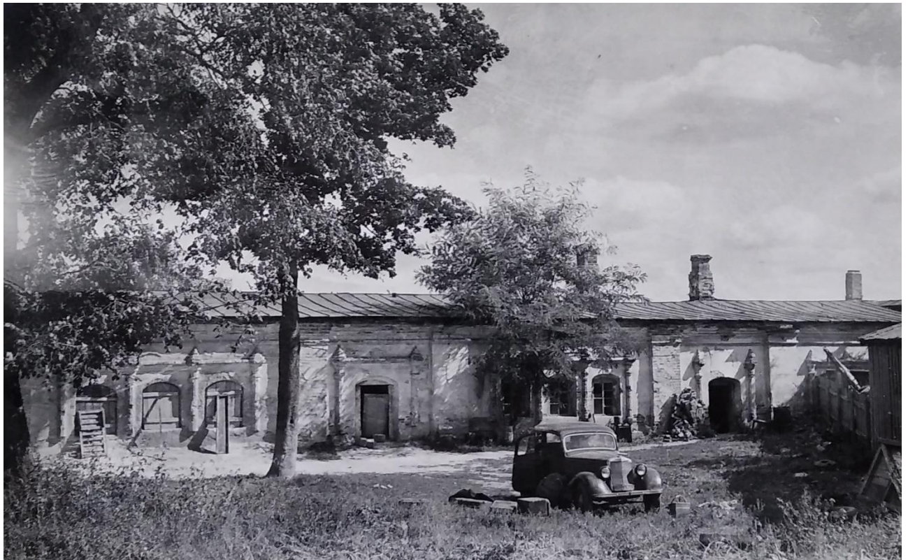
Іл. 2. Східний корпус келій. Правий бік західного фасаду
