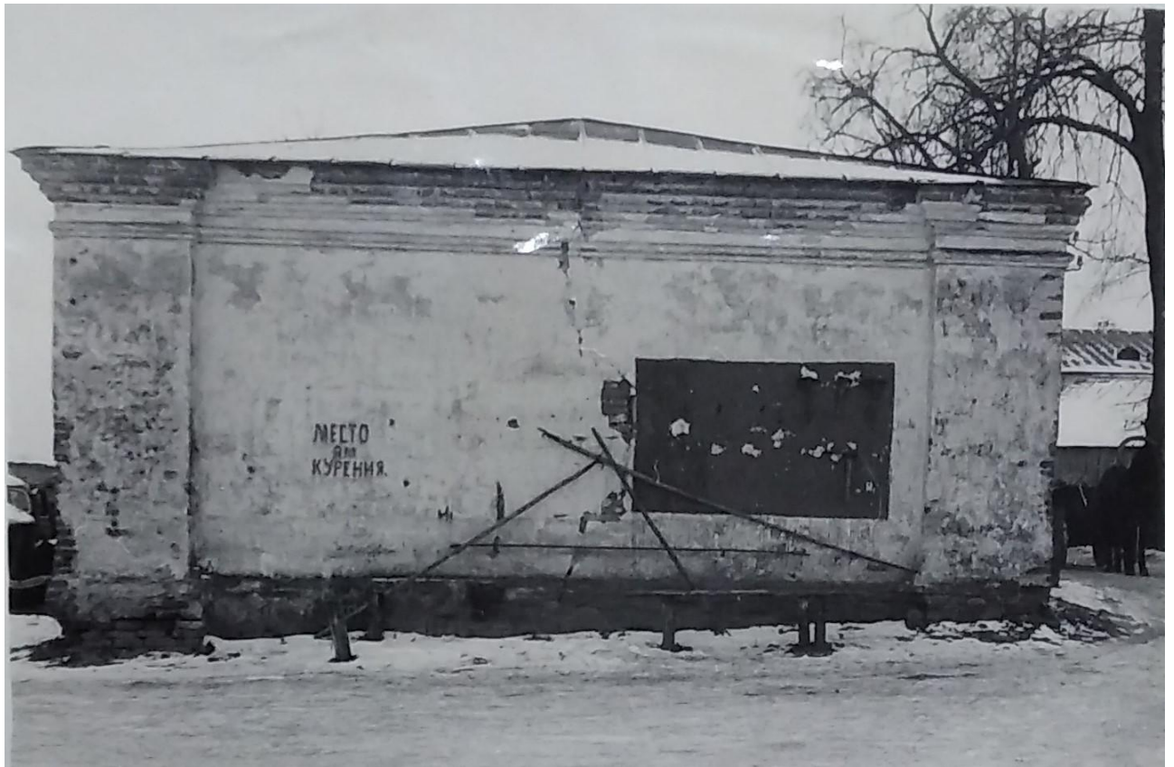
Іл. 4. Східний корпус. Північний фасад
