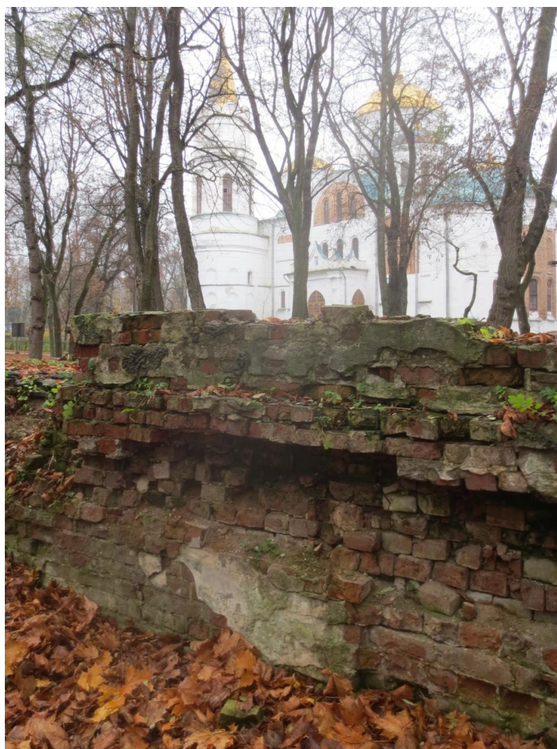
Гл. 11. Чернігів. Листопад 2022 р. Залишки цегли фундаменту колишнього пансіону чоловічої гімназії. (з мережі Інтернет)
