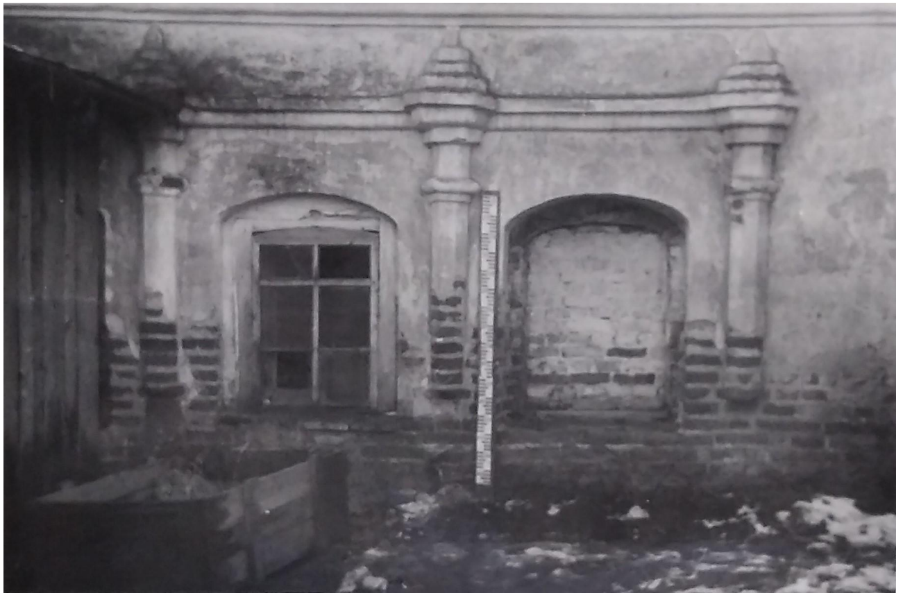
Гл. 8. Південно-західний корпус. Фрагмент північного фасаду
