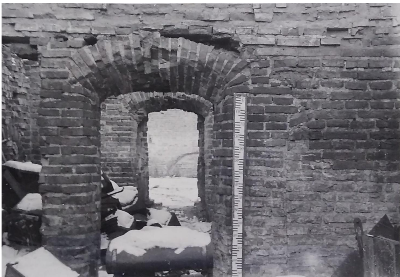
Лл. 15. Північний корпус. Інтер'єр середньої кімнати східного ризаліту. Дверний отвір на північній стіні
