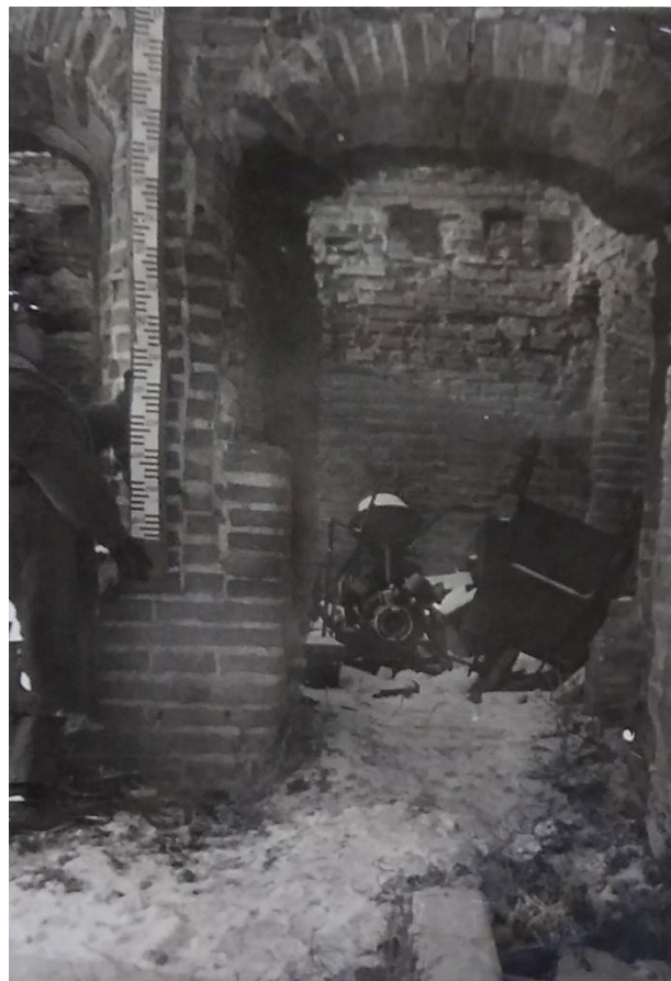
Гл. 13. Північний корпус. Дверний отвір східного фасаду
