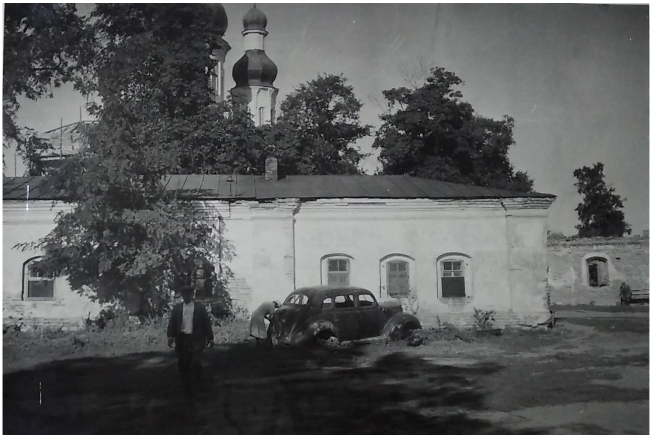
Іл. 3. Східний корпус келій. Права частина східного фасаду
