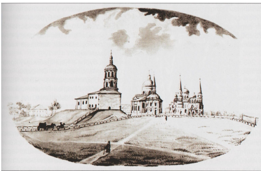
Рис. 3. Будівля Чернігівського колегіуму та собори. Гравюра першої половини XIX ст.
