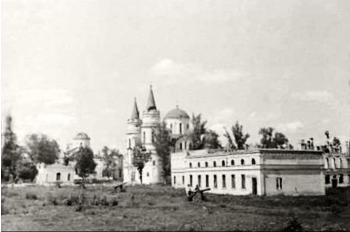
Світлина №13. Чернігів. Частково зруйнована будівля колишнього пансіону чоловічої гімназії. 1943 рік. (з мережі Інтернет) URL: https://uk-ua.facebook.com/groups/photoche/ (дата звернення: 05.11.2021)
