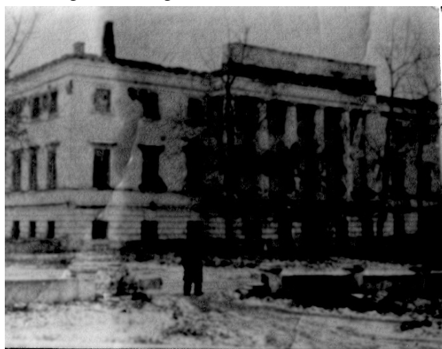
Світлина №12. Чернігів. Будівля колишньої чоловічої гімназії. 1943 р. Національний архітектурно-історичний заповідник «Чернігів стародавній». Інв. № КН-764/23
